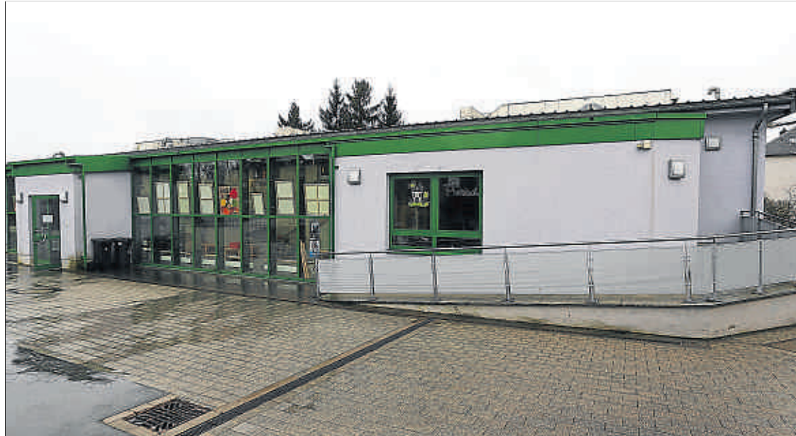
Die Gemeinde Sandweiler braucht dringend eine neue „Maison relais“.
